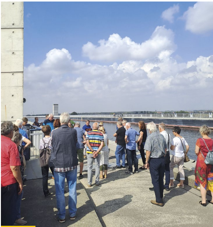
Europas größte Stahlkonstruktion: Die Trogbücke führt den Mittellandkanal bei Elbe-Kilometer 339,11 über die Elbe. Übrigens: Auf der Brücke gilt strikter Einbahnverkehr
