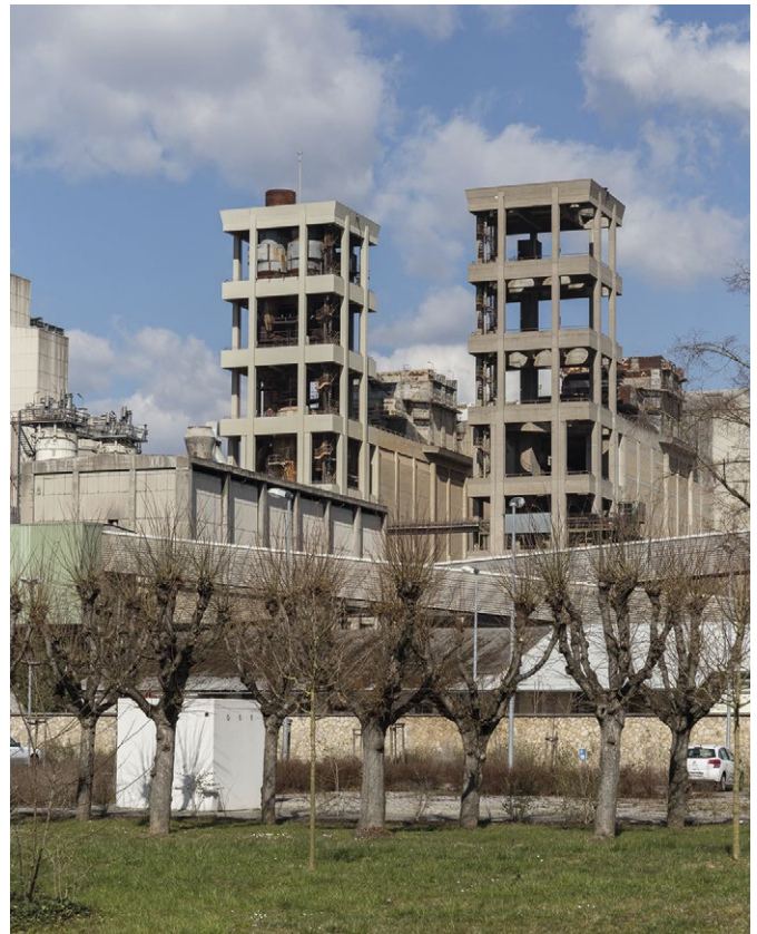
Denkmalgeschützte, stillgelegte Wärmetauschertürme Dyckerhoff Zementwerk Foto: Ansgar Koreng
