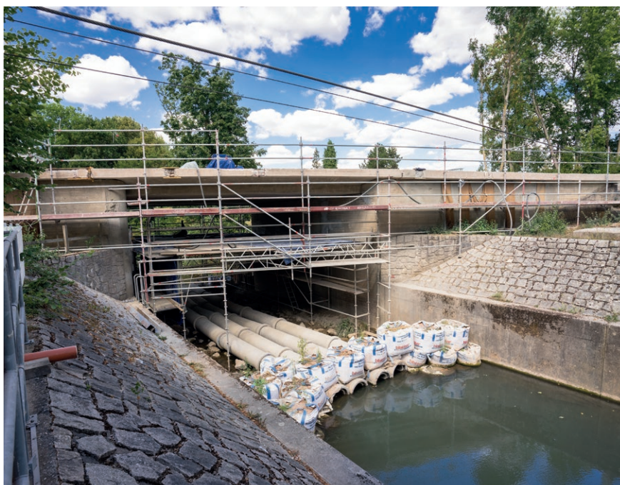
Sanierungsarbeiten an der Brettachbrücke in Neuenstadt am Kocher (Foto: HKM Video)
