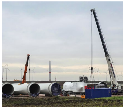
Die Rotorblätter mit einer Länge von 75 Metern liegen zur Montage.
