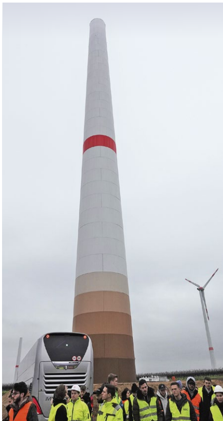
Der Turm der Windkraftanlage wird bei ihrer Fertigstellung 166 Meter in die Höhe ragen.
