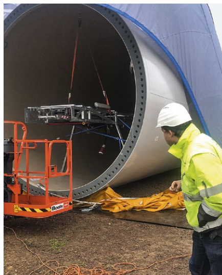
Einblick in das Innere eines Stahlrohrturmtails.
