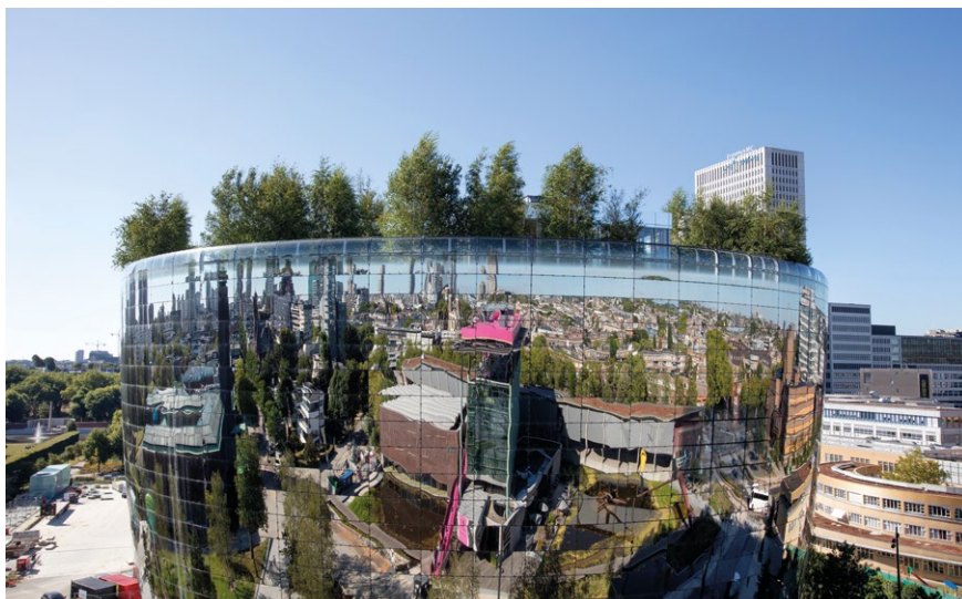
Museum Boijmans Van Beuningen in Rotterdam: Die durch den Bau weggefallenen Bäume werden auf dem Dach ersetzt und dienen als Erholungsraum für Besucher (Bild: AdobeStock/Peter de Kievith)
