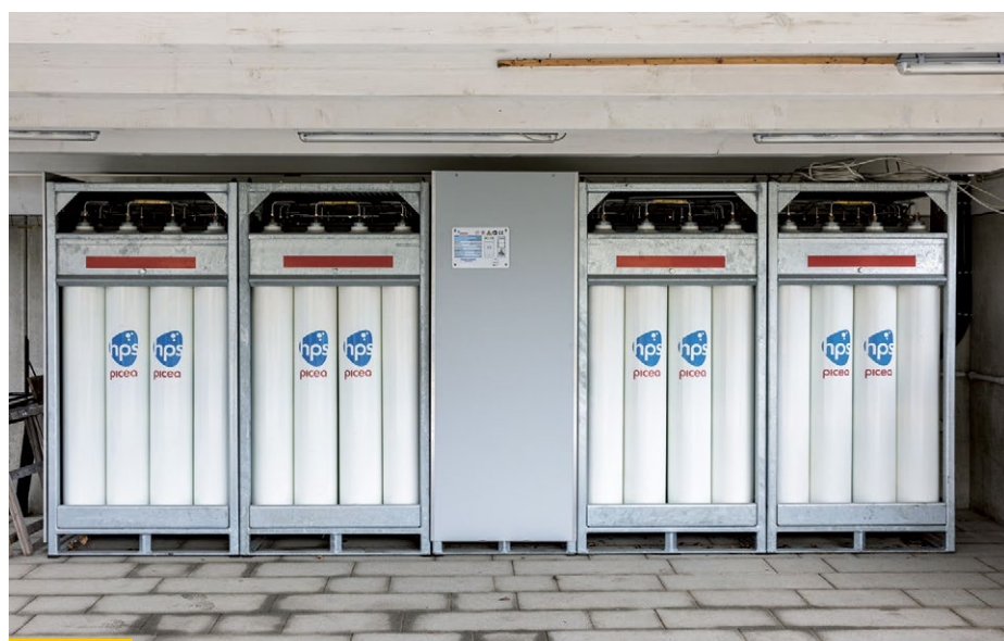
Das Herzstück der Sanierung: Das innovative System „PICEA“ ist das erste Solar-Wasserstoff-System für den Privatgebrauch
