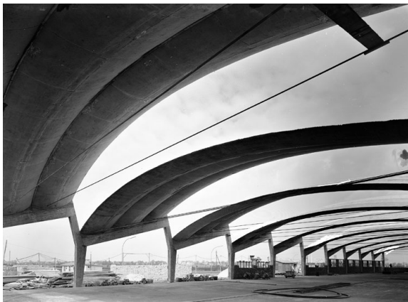
Hamburgisches Architekturarchiv Bestand Otto Rheinländer 293/26. Baustelle Sheddachhalle mit HP-Schalen
