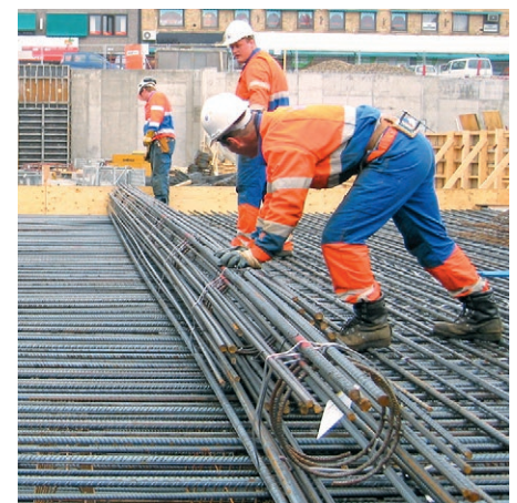
Ohne Bewehrung geht nichts.
