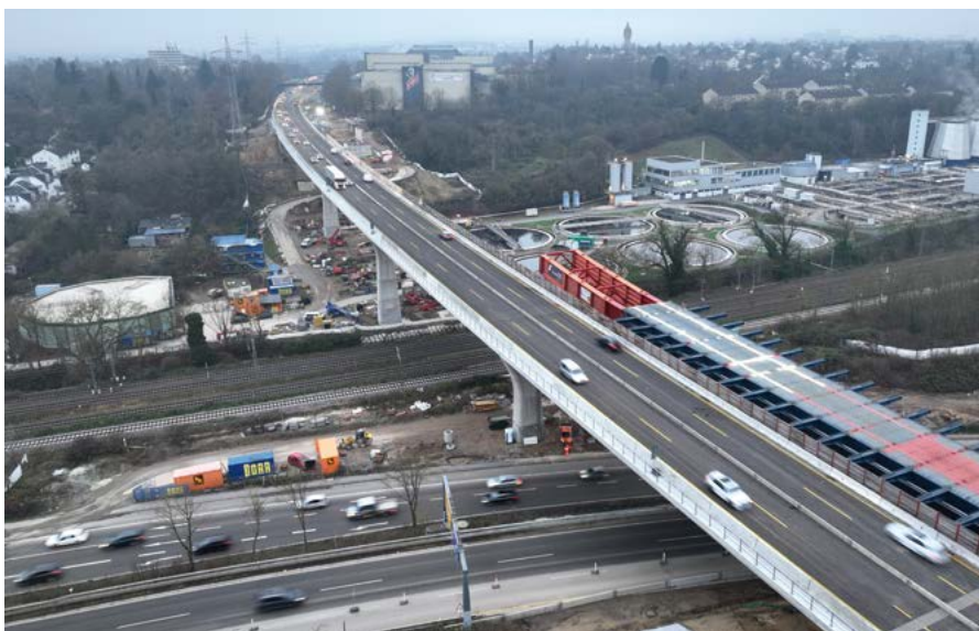
Neugebauter Abschnitt der Salzbachtalbrücke, Foto: Autobahn GmbH des Bundes
