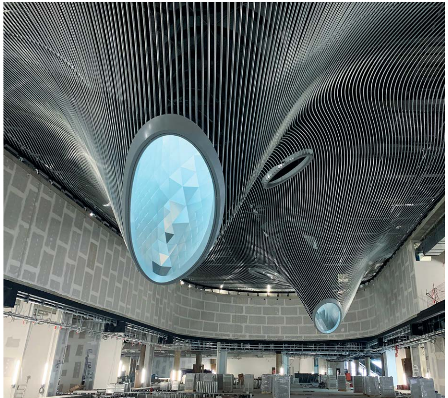
Die „Lava-Decke“ getaufte Deckenkonstruktion des Marktplatzes zwischen Sicherheitskontrolle und Gates.
