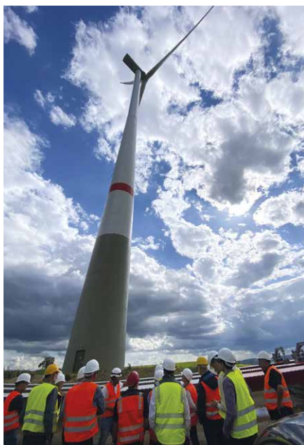
Die Windkraftanlagen von Enercon erreichen je Anlage eine Gesamthöhe von 247 m, eine Nabenhöhe von 166 m, einen Rotor-Durchmesser von 160 m und bringen es auf ein Gesamtgewicht von 3000 Tonnen. Damit produziert eine Anlage pro Jahr bis zu 20 Mio kWh.
