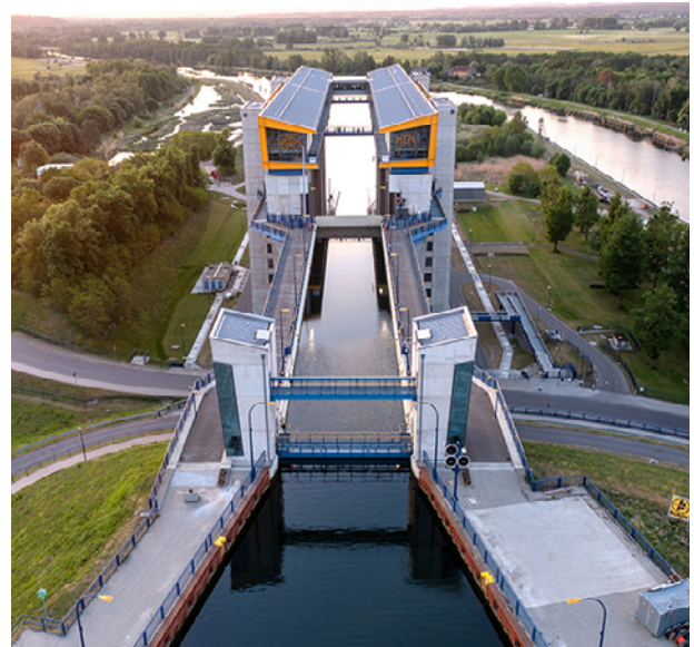
Das Neue Schiffshebewerk in Niederfinow | © Bundesanstalt für Wasserbau Karlsruhe
