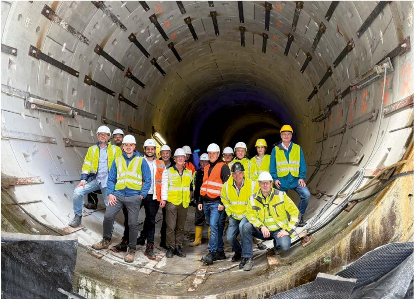
Die Teilnehmerinnen und Teilnehmer des Ingenieurdialogs hatten die Möglichkeit, einen Einblick in die Baustelle des Projekts „Stadtbahn Europaviertel“ zu erhalten. Foto: IngKH
