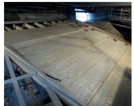
Neue Holzunterkonstruktion: fertig verschraubte Schalung; 2016 (Abb. 4).
