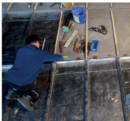
Neue Bleibekleidung: fertiger Stufenbereich; 2016 (Abb. 5).
