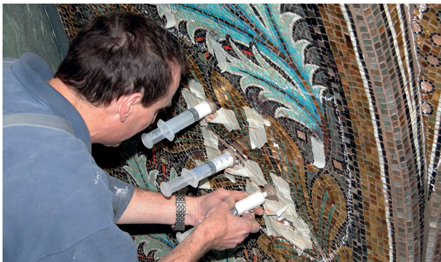
Hinterfüllen der Hohlstellen mit Kalkmilch; 2007 (Abb. 6).
