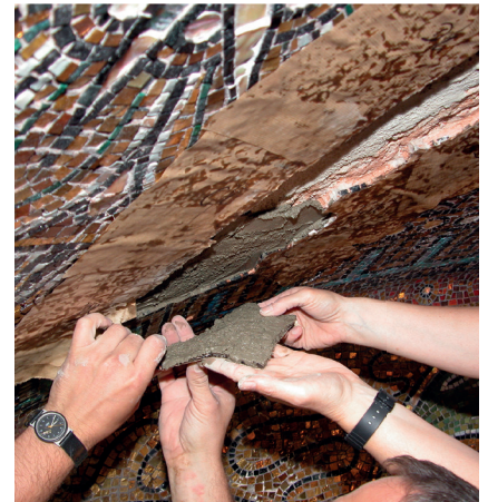
Neusetzen des Mosaikstücks in Mörtel; 2009 (Abb. 9).
