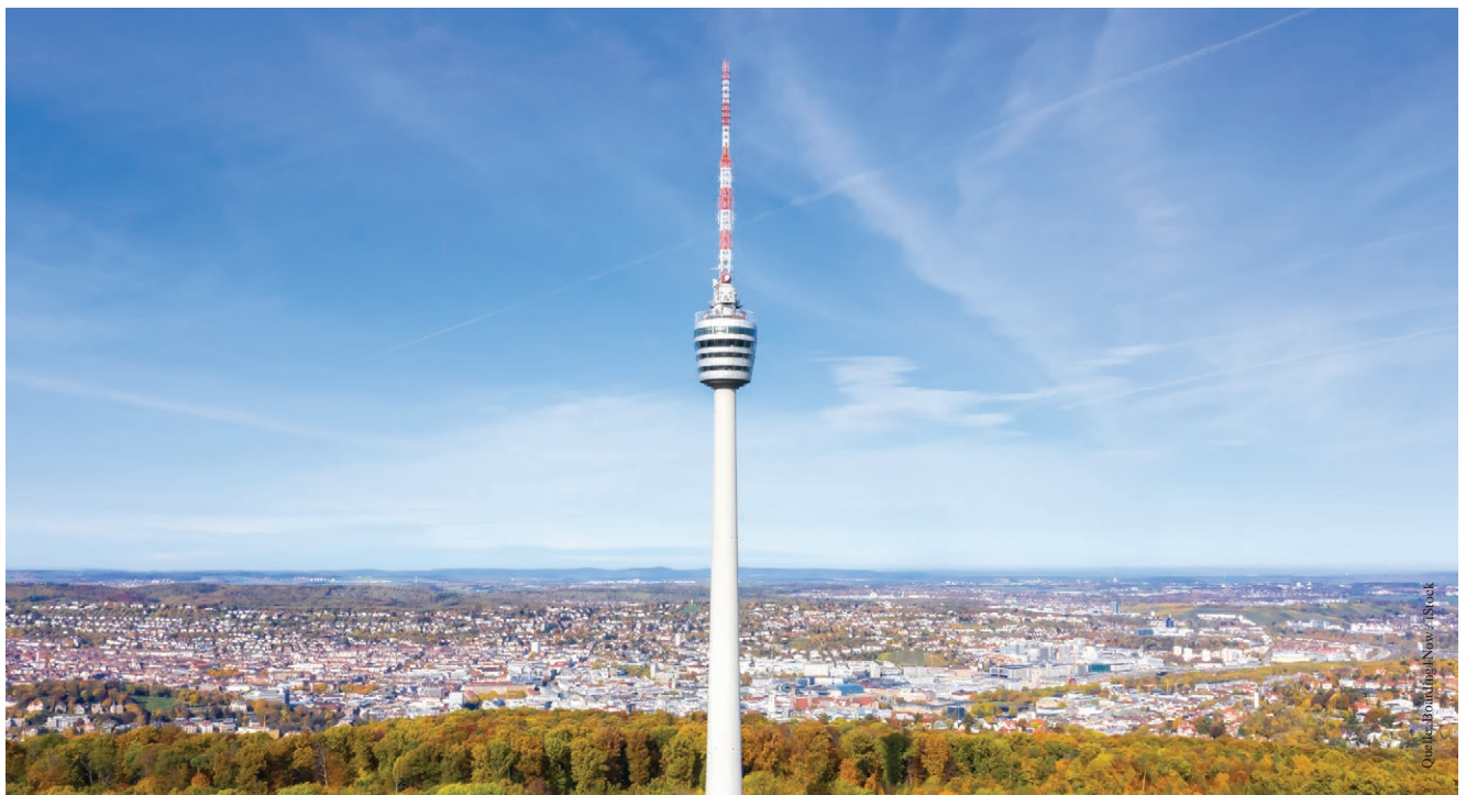
Der Stuttgarter Fernsehturm ist das weithin sichtbare Wahrzeichen der badenwürttembergischen Landeshauptstadt; mit seiner Idee, den Stahlbetonturm mit Aussichtsplattform zu bauen, revolutionierte Bauingenieur Fritz Leonhardt den Turmbau.
