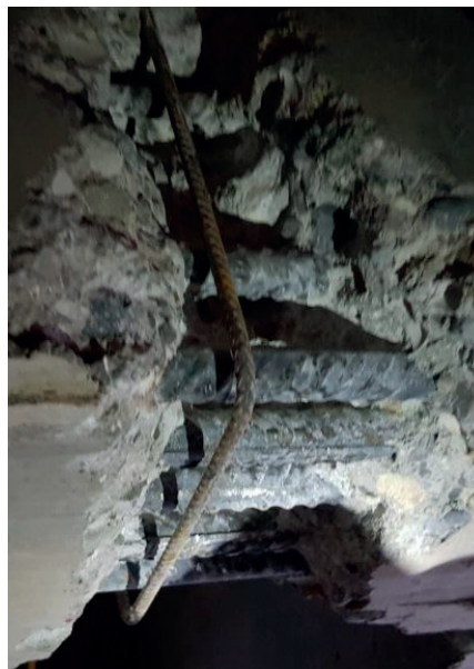
Exemplarische Bilder der Beprobung der Unterzüge (Stahlbeton-Rippendecke)
