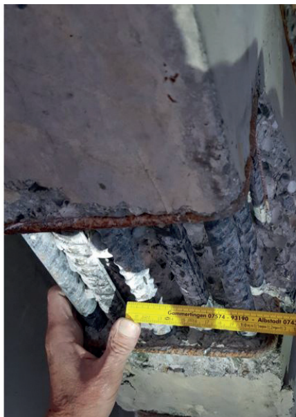
Exemplarische Bilder der Beprobung der Unterzüge (Stahlbeton-Rippendecke)
