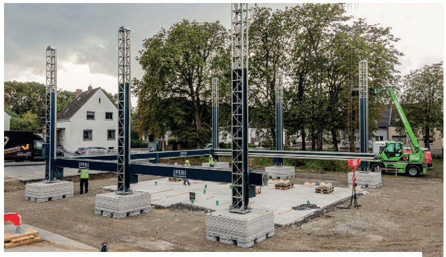
Druck des ersten Wohnhauses in Deutschland mit dem Portaldrucker BOD2 in Beckum.
