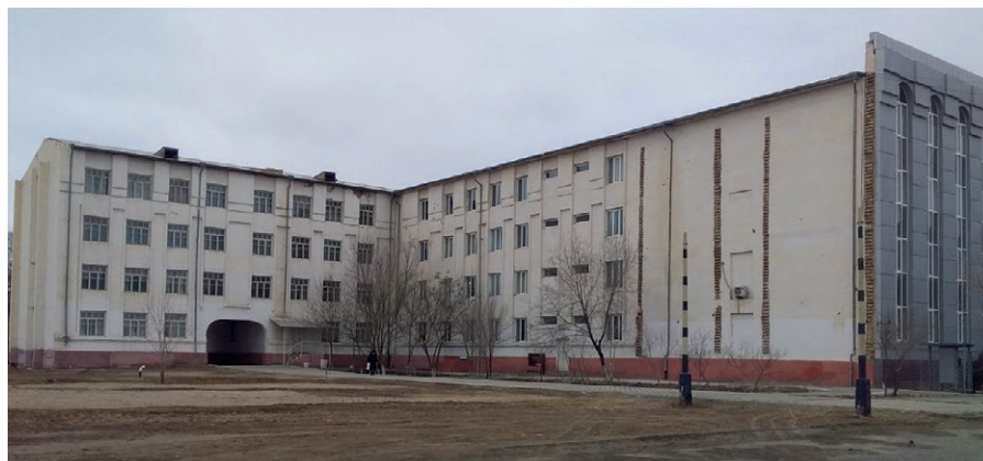
Die sächsischen Regionalgruppen von Ingenieure ohne Grenzen unterstützen die Sanierung dieses Gebäudes in Usbekistan.
